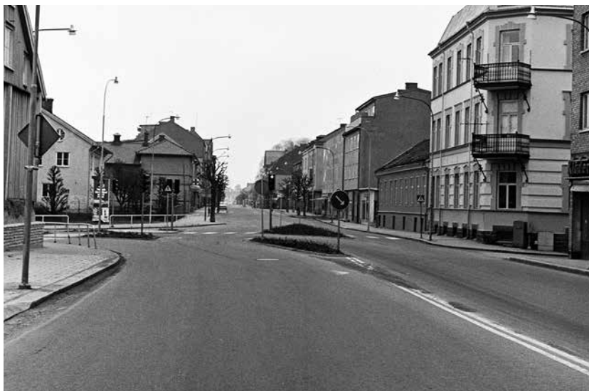
Edsgatan mot norr, nr 2 närmast i bild till vänster. Foto juni 1968. SG00032-008
