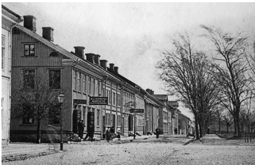
År 1852 öppnade Zettergren bokhandel handlare Caulvins hus, i nordöstra hörnet av Drottning- och Edsgatan. Fem år senare köpte han och hustrun grannfastigheten, Drottninggatan 18. Dit flyttades då bokhandeln liksom Vänersborgs Sparbanks kontor där Zettergren under ett antal år var kassör. Foto visande Caulvins hus i förgrunden, cirka 1880-tal av okänd fotograf. (Vänersborgs museum)
