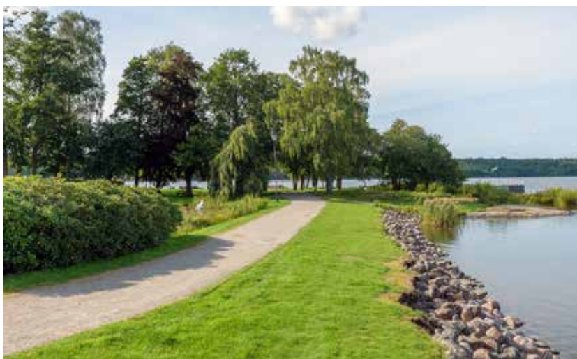
Till följd av översvämningens verkningar valde man att höja delar av promenadvägen och vid näckrosdammen förstärkte man med en strandskoning. Augusti 2023. Foto: Karl Bernling.
