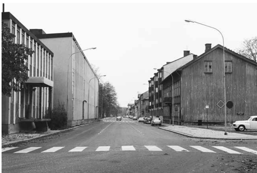
Drottninggatan västerut. Närmast t.h. det rivningsmogna nr 40. Foto 1969. (SG00029-001)
