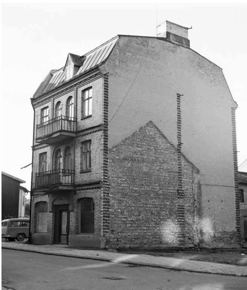
Denna tegelbyggnaden stod på Kronogatan 52 i vad som förr benämndes Östra Haga. I gatuplanet fanns Andersson och Johanssons specerihandel och i det lilla hörnhuset vid Östergatan, som här endast är ett avtryck på gavelväggen, låg Hagaboden. Tegelhuset revs 1965 för att lämna plats åt Riksbyggens två fyra våningsbyggnader med 104 lägenheter och ett för den tiden gigantiskt garage under jord med plats för 90 bilar. Saneringen av stadens kvarter var nödvändig men den raderade raskt och skoningslöst ett stort stycke av stadens bebyggelsehistoria, något som Stellan Granat var högst medveten om då han var ute med kameran och dokumenterade sin föröddas stad. Foto 1963. (SG00060-003)
