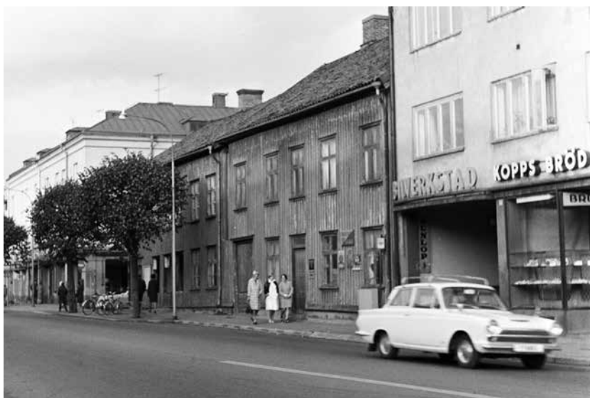
Den gamla träfastigheten på Edsgatan 9-11 där bl.a. A. Joh. Larsson hade sin maskinfirma revs under oktober 1966. Foto september 1966. (SG00032-003)
