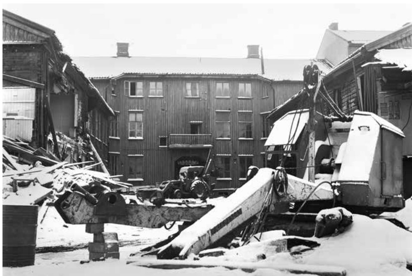
Rivningen av Drottninggatan 40 pågick januari – mars 1970. (SG00028-003)
