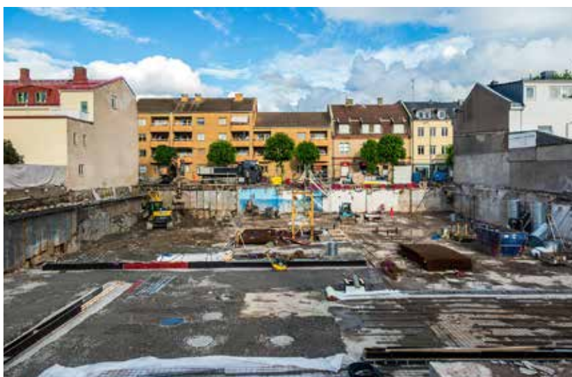
Ett sexvåningars bostadshus med entréer från gatan samt ett tvåvåningshus på bakgården kommer under 2020-21 att uppföras på Edsgatan 24. Juni 2020. Foto: Karl Bernling.
