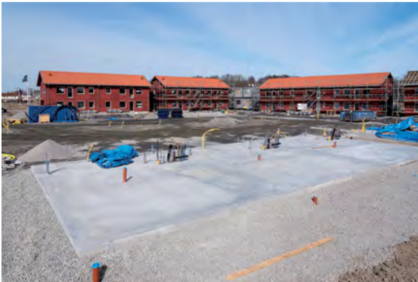
Nybyggnation på Holmängen april 2018. Foto: Karl Bernling.
