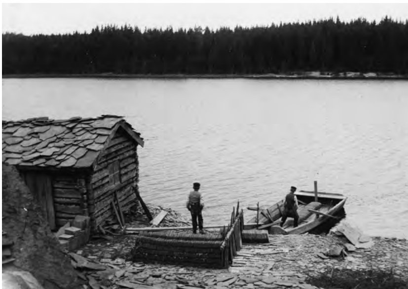
Lastning av takskeffer vid Hällans Skifferverk i Dalsland. Vid skifferverket, som hade en betydande produktion, fick Hjalmar Lindedal sin första riktiga anställning år 1867. Foto: Emil Almqvist, Skara. (Vänersborgs museum)
