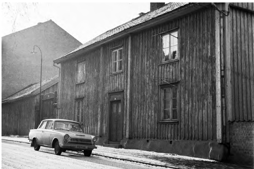
Gamla fattighuset på Residensgatan omkring 1965. Rivet 1971.
