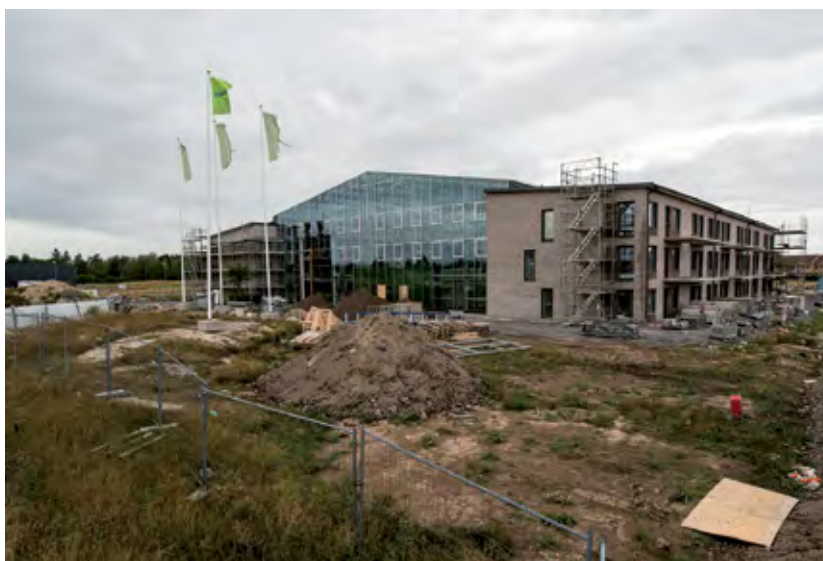
Bovieran på Holmängen under uppförande augusti 2018. Foto: Karl Bernling.
