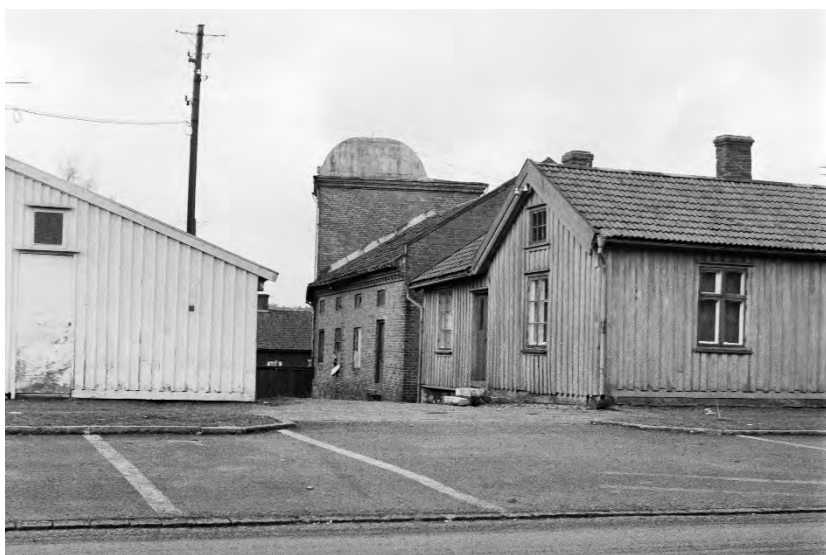
Kokhusgränd i kvarteret Syrenen, med det gamla mälteriet från 1840-talet i bakgrunden. Vinkelbyggnaden t.h. kallades allmänt för "Garna hörnet".
