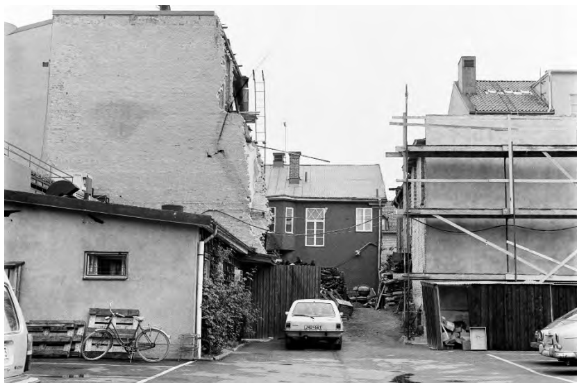
Nordfelts konditori bygger ut, 1981.
