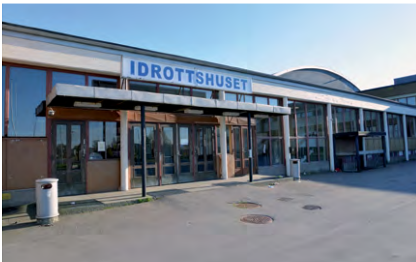
Idrottshusets entré, exteriör. Ombyggnad påbörjades sommaren 2014. Maj 2014. Foto: Karl Bernling
