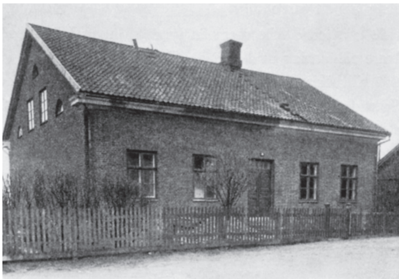
Epidemisjukhuset i Vänersborg uppfördes 1859-60 på adressen Edsgatan 53. Sjukhusets syfte var att vid plötsliga farsoter, som exempelvis koleran och smittkoppsepidemier, avskilt kunna hysa smittbärande patienter. Mellan farsoterna begagnades sjukhuset som bostäder där hyresgästerna fick vara beredda att med kort varsel lämna sina bostäder om en epidemi drabbade staden. Sjukhusbyggnaden inköptes av Vänersborgs Söners Gille 1921 för att, kraftigt ombyggt, rymma Gillets Ålderdomshem.
