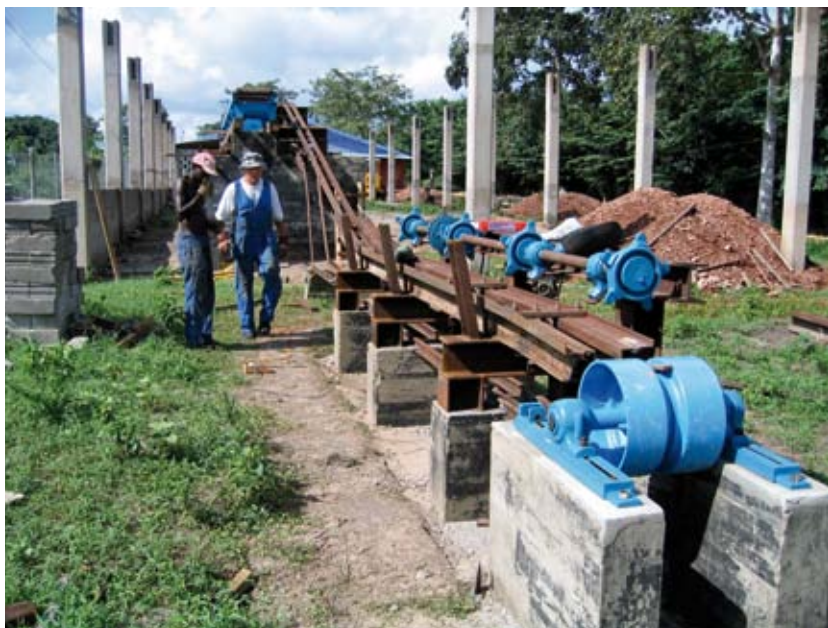
Bernt Hallin och Boniface under återuppbyggnaden av sågverket på Zanzibar, april-maj 2005.
