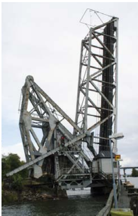
Bron i uppfällt läge. Motvikten viks in under tornet med manöverutrustningen.
