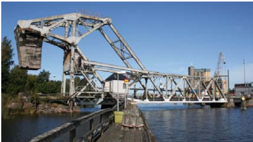
Klaffbron i Vänersborg sedd från söder. Linjen mot Öxnered går ut till vänster i bild.
