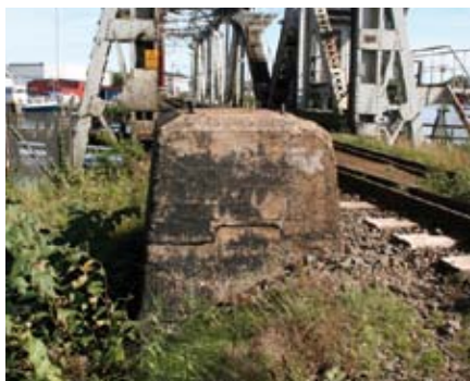
Två av de plintar som användes vid gjutningen av motvikten står ännu kvar vid spåret.
