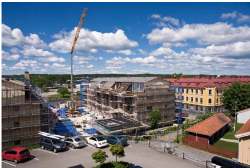
Kvarteret Vallmon juni 2012. Bygge pågår av nya bostäder. Foto: Karl Bernling.
