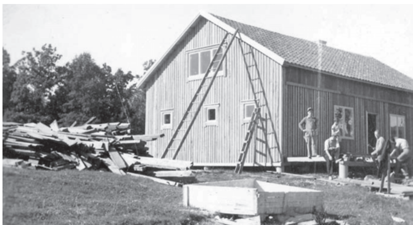
Klubbhuset i Sikhall under uppförande 1952.
