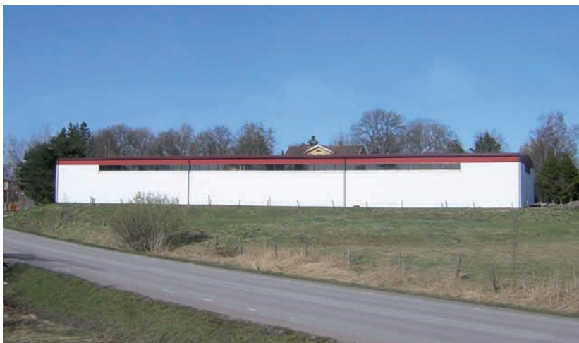
Maskinhall uppförd på 80-talet.
