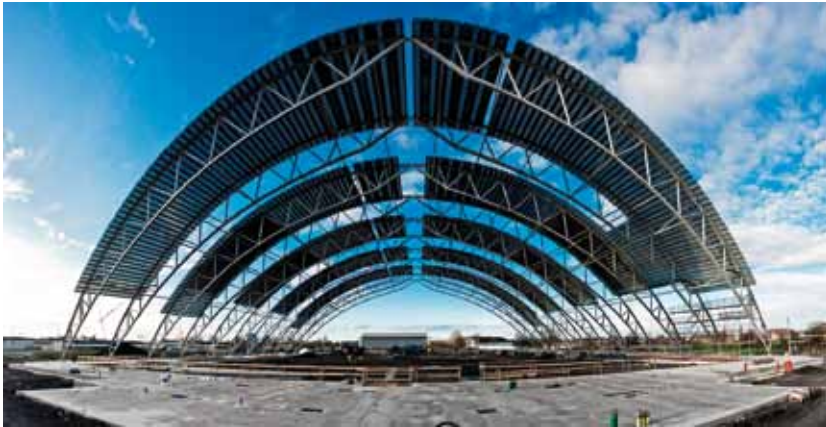
Arena Vänersborg invigdes den 24-25 september 2009. Arenan tar 3 300 åskådare. Arena Vänersborg är tänkt att användas för olika typer av evenemang. Foto: Karl Bernling.
