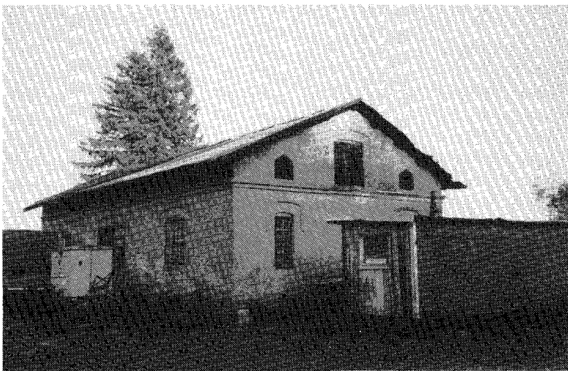
Proviantmagasinet vid Grunnebo järnvägsstation. Uppförd före 1863. Även denna kulturbyggnad står kvar och är förmodligen en av de allra äldsta byggnaderna i Grunnebo stationssamhälle. Foto 1992: Bertil Stenberg.
