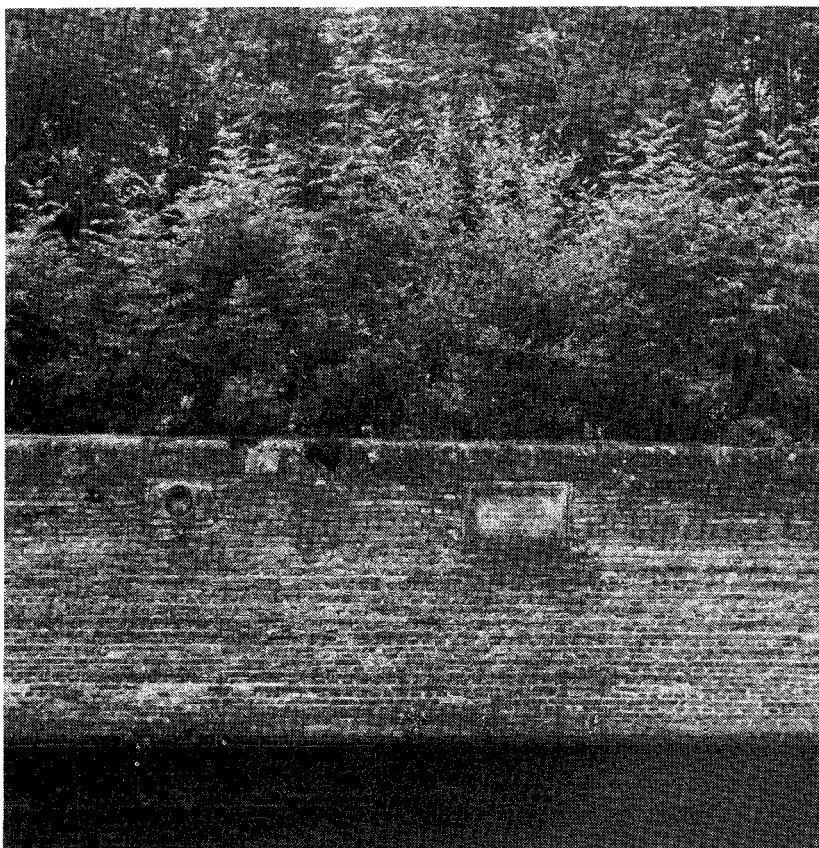
Detalj av västra sidan av Gustafs slussar med inskriptionsplatta. Foto c:a 1970 Stellan Granat.
