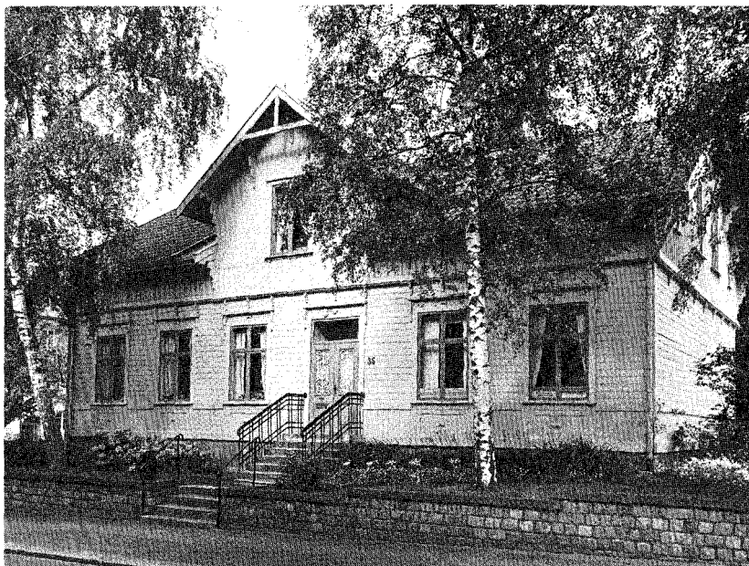
Fastigheten Residensgatan 35 fungerade som länsveterinärhoställe åren 1900-1944.
