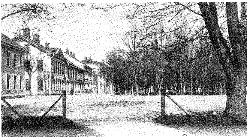
Kungsgatan från korsningen med Vallgatan och västerut. Hörnhuset med fronton förvärvades 1875 av Frimurarelogen Råta Vinkeln, liksom grannhuset, Kungsgatan 21. I detta inrymdes stadens gästgiveri på 1830-40-talen och åter från 1854. Restauration kom att drivas där fram tills att huset revs 1961. I bakgrunden ses Stadshotellet och t.h. kyrkan.
