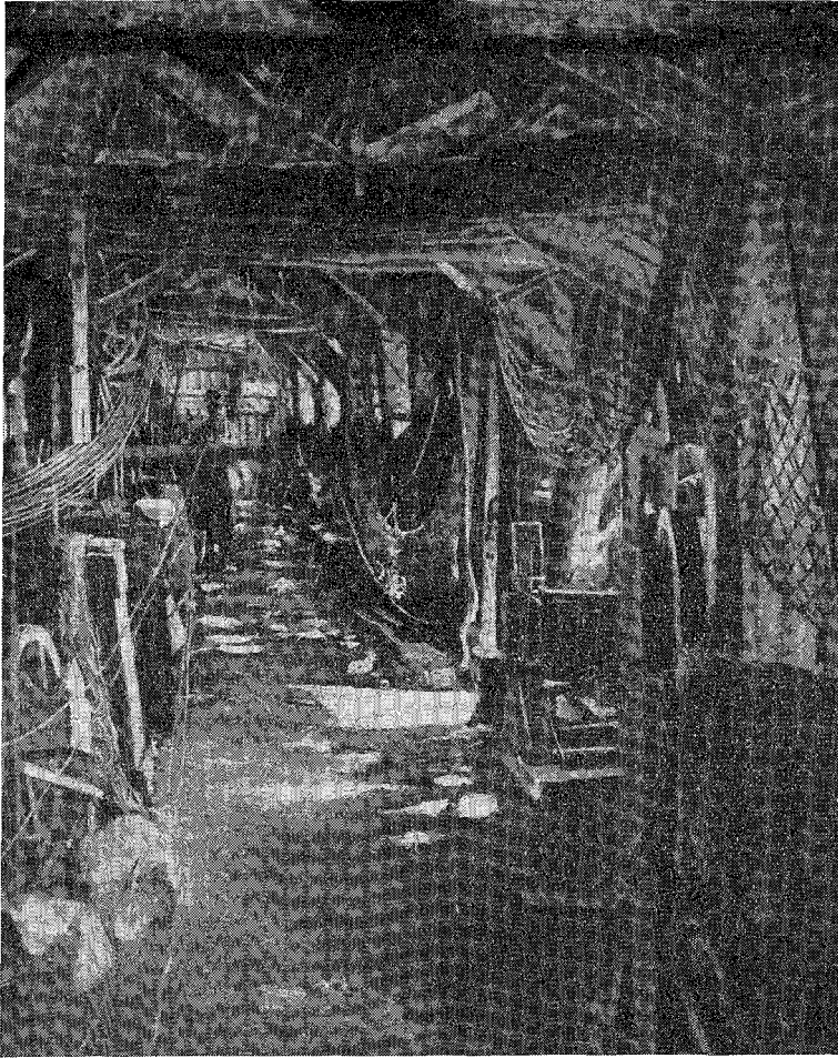
INTERIÖR FRÅN EN REPSLAGERIVERKSTAD.
